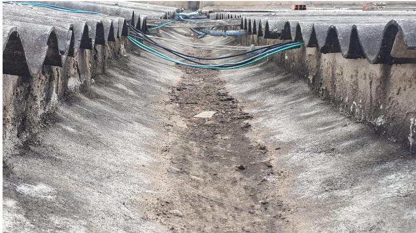
Foto 4 – Calha existente e gambiarras elétricas
