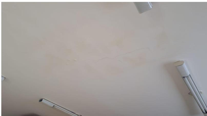
Foto 17 – Infiltração na laje
