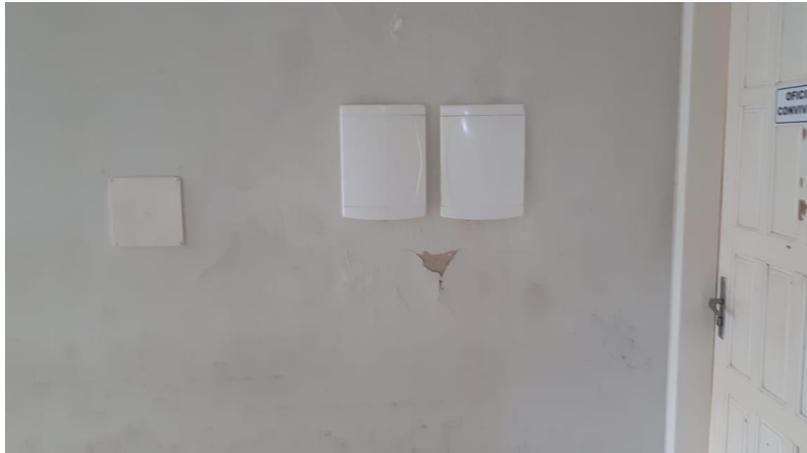
Foto 22 - Quadros de distribuição existentes com infiltração
