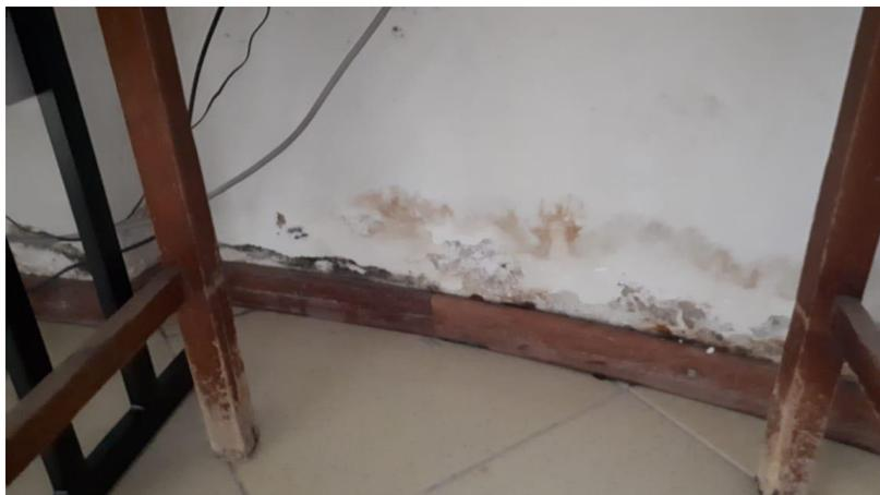
Foto 16 – Rodapé de madeira existente e infiltração
