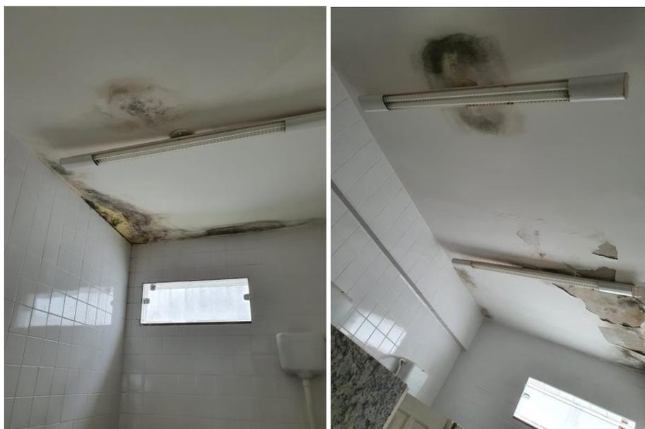
Foto 20 - Infiltração na laje dos banheiros
