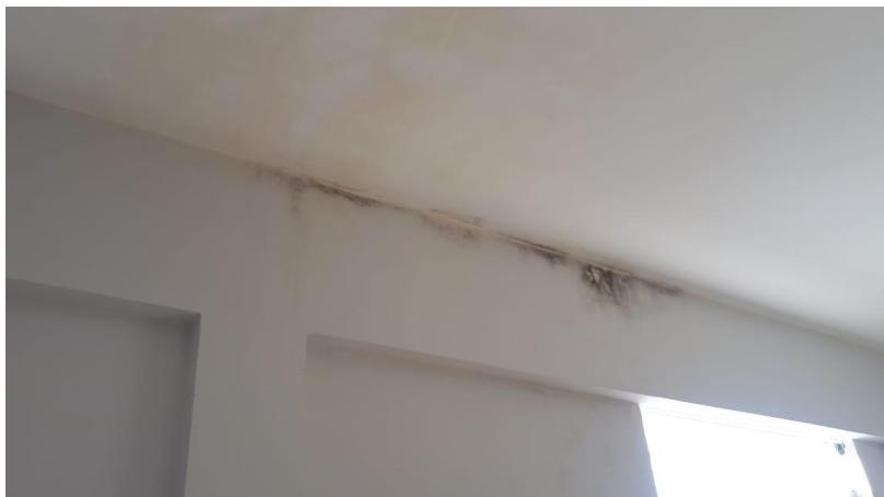
Foto 19 - Infiltração na laje e paredes
