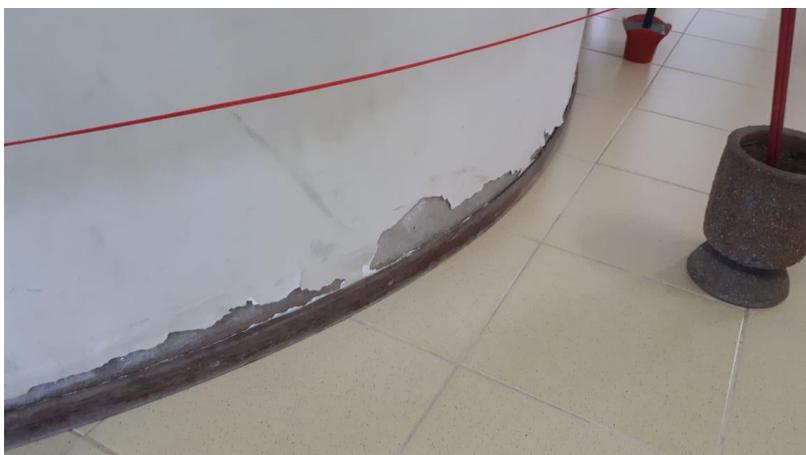
Foto 15 – Rodapé de madeira existente e descascamento da pintura
