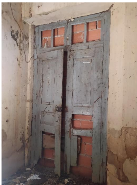
Foto 13 – Porta existente internamente no Hall escada – a ser substituída e/ ou restaurada
