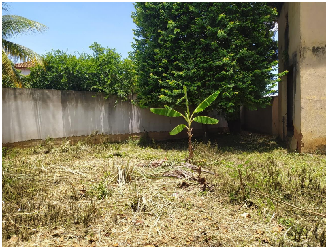
Foto 34 – Vista muro fundos edificação – executar complemento de chapisco e reboco
