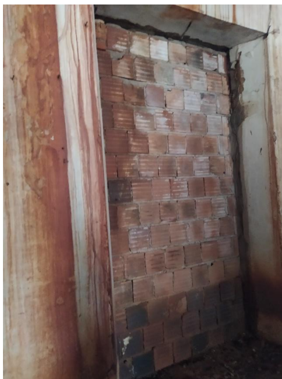
Foto 7 – Abertura de porta fechada por alvenaria em fachada lateral – dim.: 1,40 x 3,00 m
