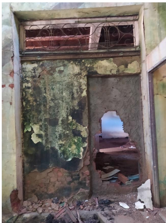
Foto 8 – Abertura de porta fechada por alvenaria nos fundos da edificação – dim.: 2,00 x 3,00 m
