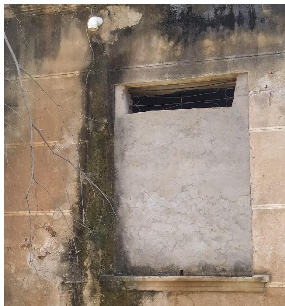
Foto 10 – Abertura de janela fechada por alvenaria fundos da edificação – dimensão 1,15 x 2,05 m
