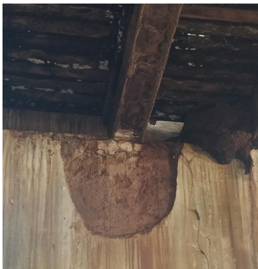
Foto 29 – Vigas de sustentação paredes em alvenaria
