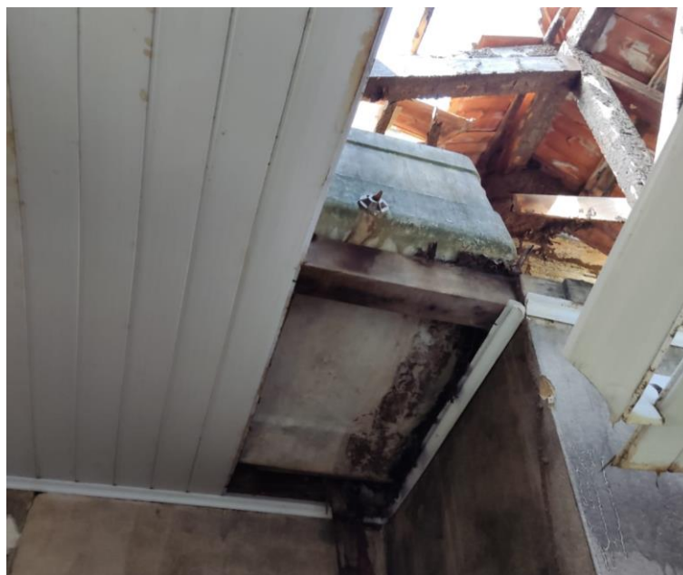
Foto 25 – Vista caixa d'água fibrocimento existente – localização: cozinha
