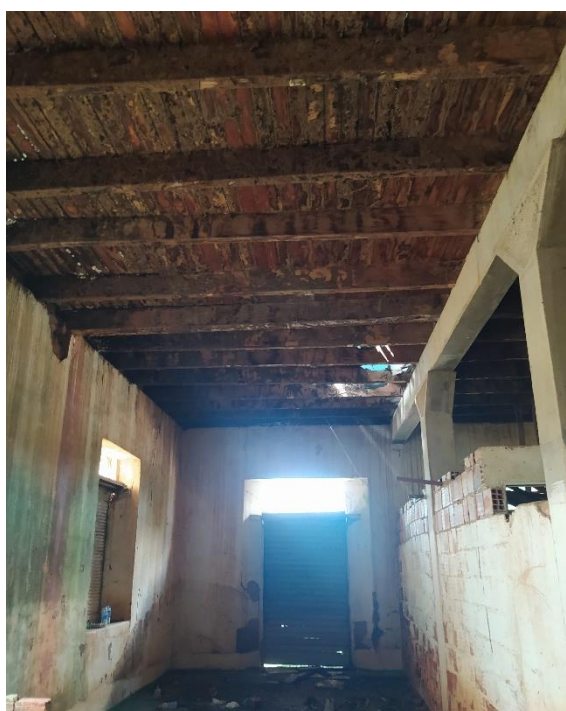
Foto 20 – Vista estrutura de sustentação piso de madeira
