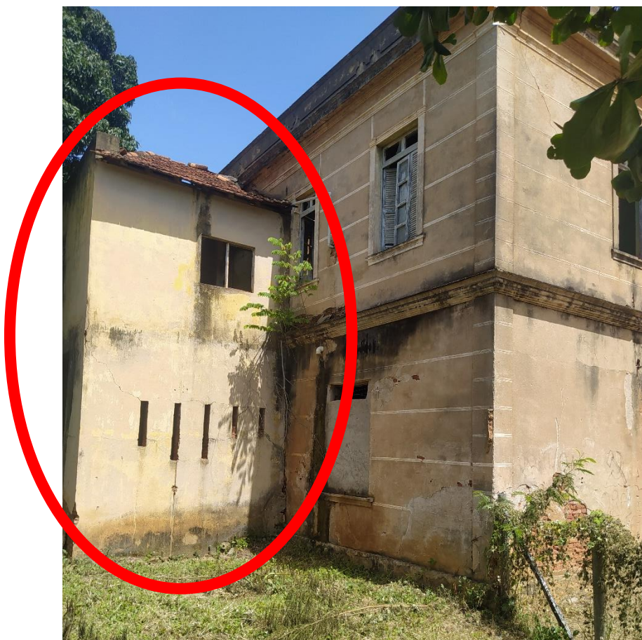
Foto 5 – Edificação anexa à existente a ser demolida
