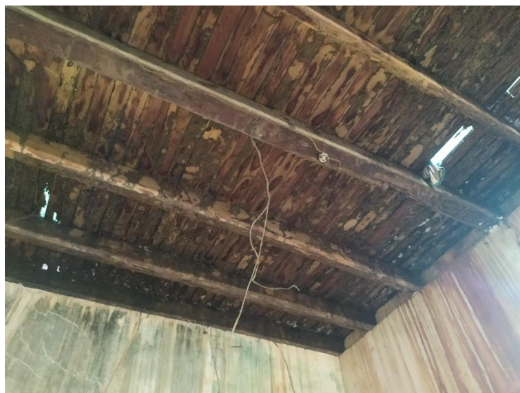
Foto 28 – Estrutura existente de sustentação assoalho
