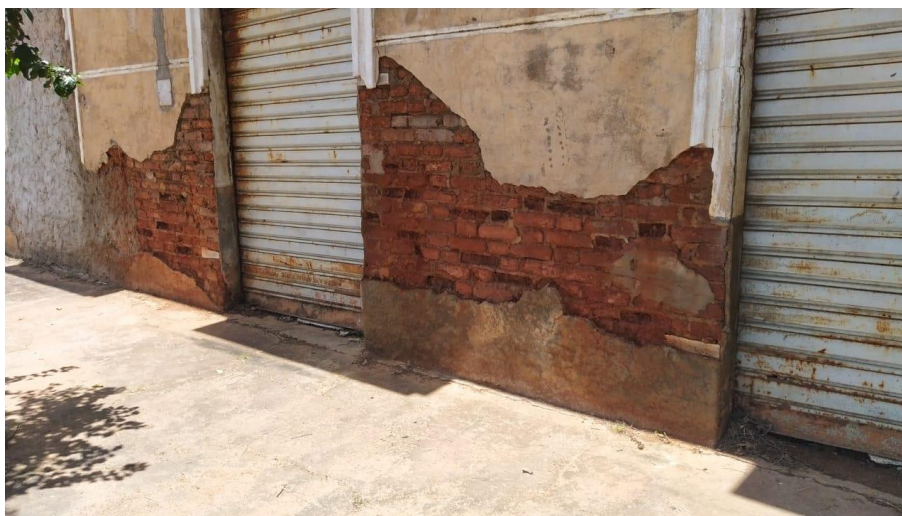
Foto 4 - Vista fachada frontal edificação existente – revestimento deteriorado a ser removido mantendo as linhas originais do local.
