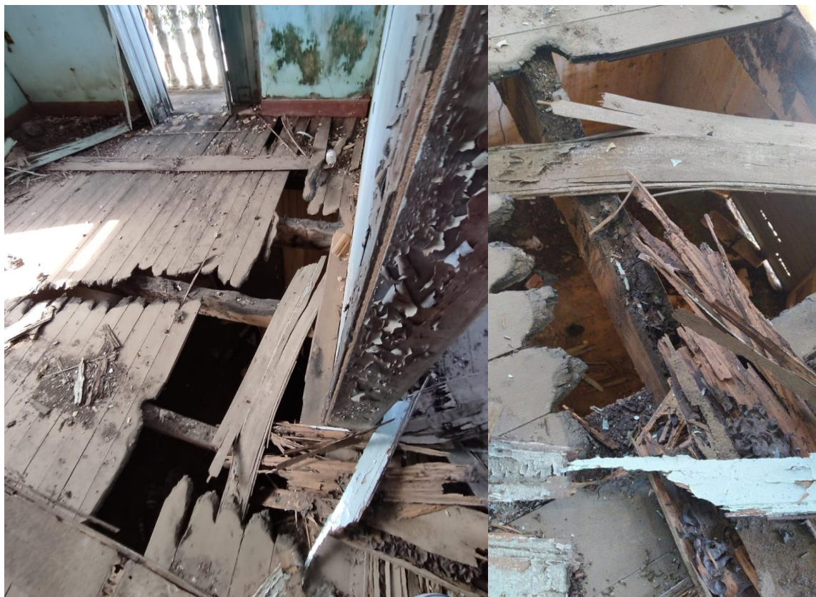
Foto 22 – Vista superior piso de madeira
