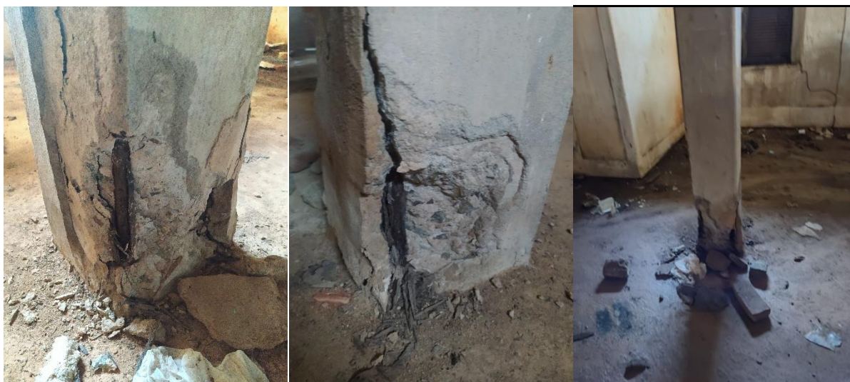
Foto 44 – Base pilar de concreto existente – fazer recuperação
