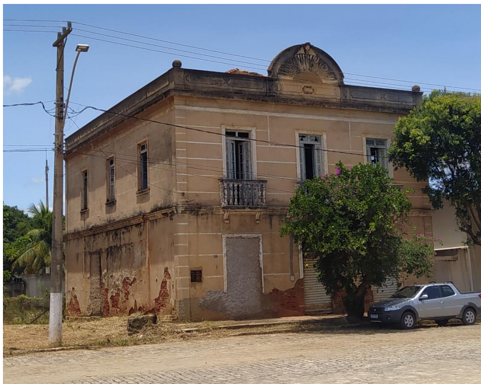
Foto 1 – Casarão Madame Albertina Holz – estado atual – JAN/2022
