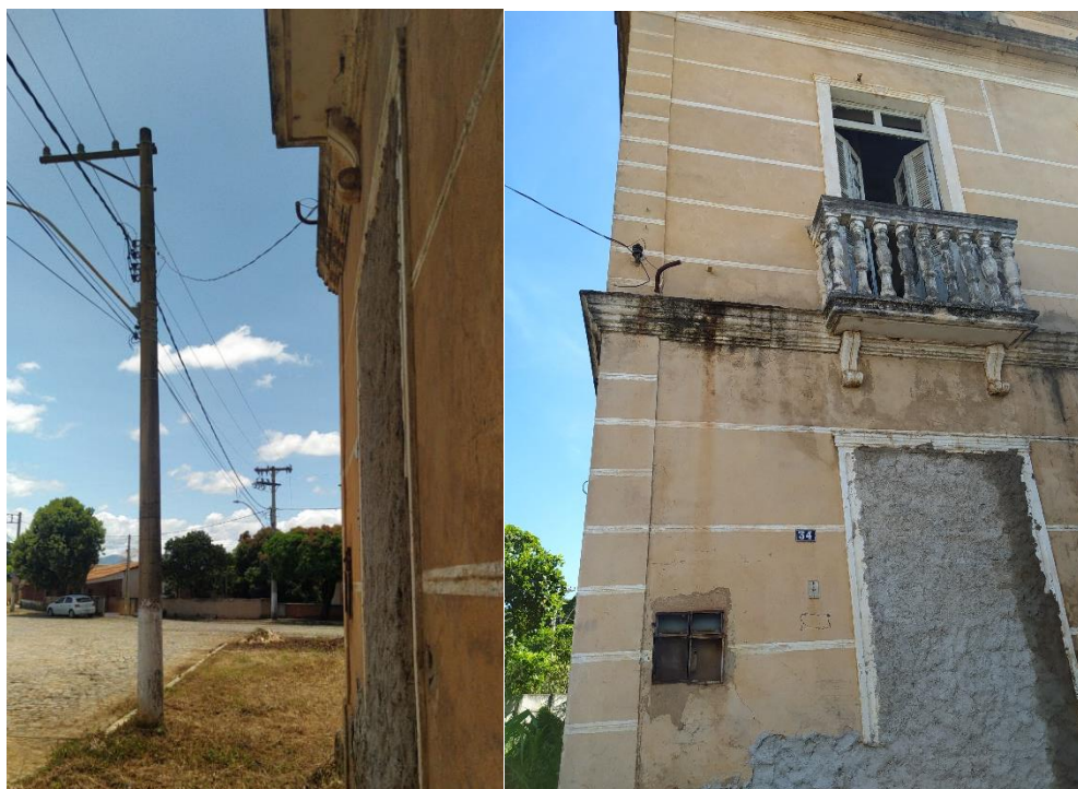
Foto 36 – Entrada existente de energia
