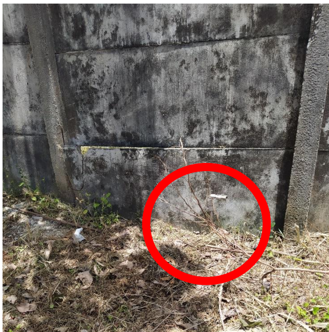
Foto 35 – Ponto entrada de água
