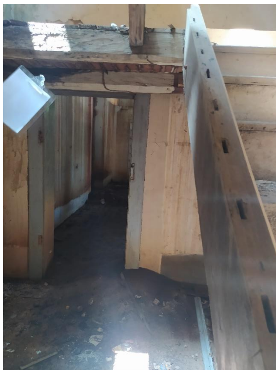
Foto 33 – Furos de encaixe guarda-corpo em escada de madeira existente
