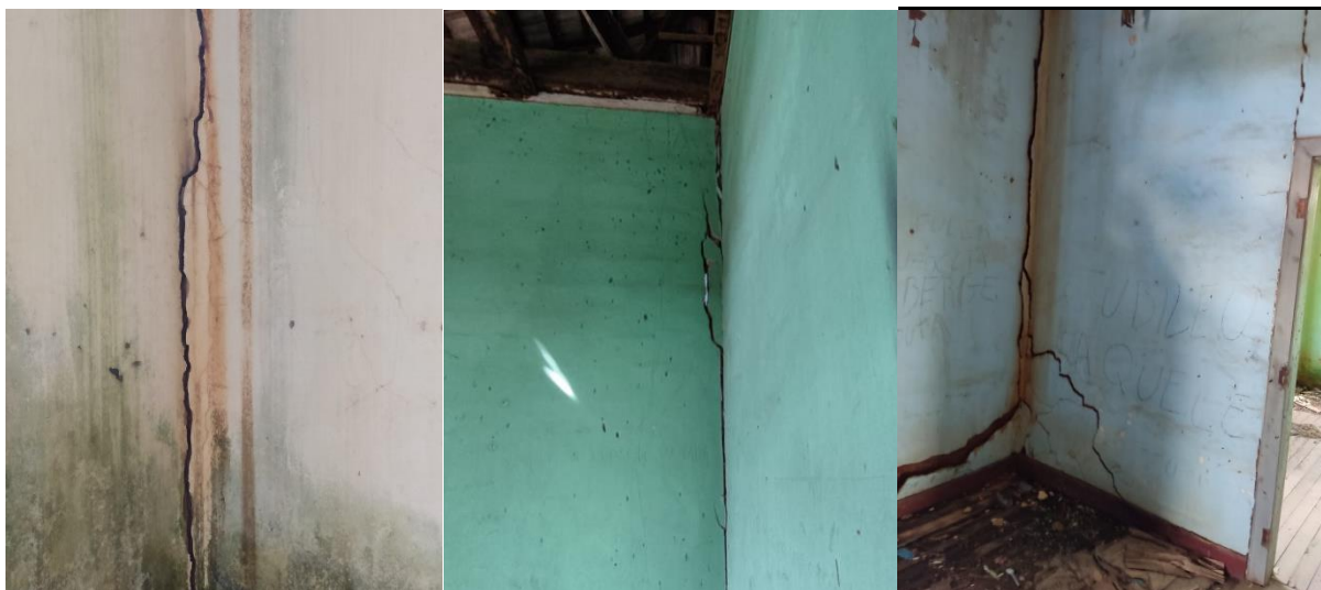
Foto 12 – Rachaduras existentes nas paredes internas da edificação
