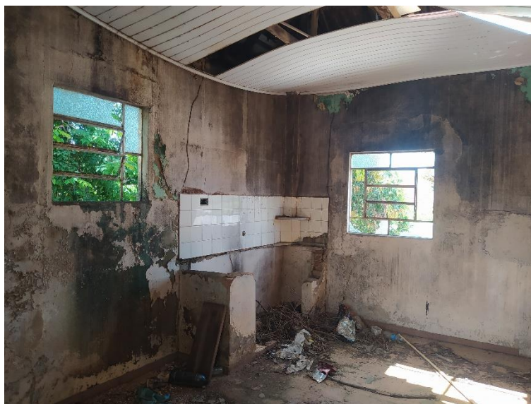
Foto 6 – Cozinha_Pavimento superior a ser demolida
