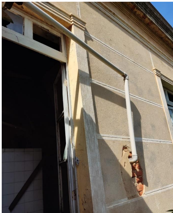
Foto 26 – Vista fundos edificação – tubulação aparente a ser retirada
