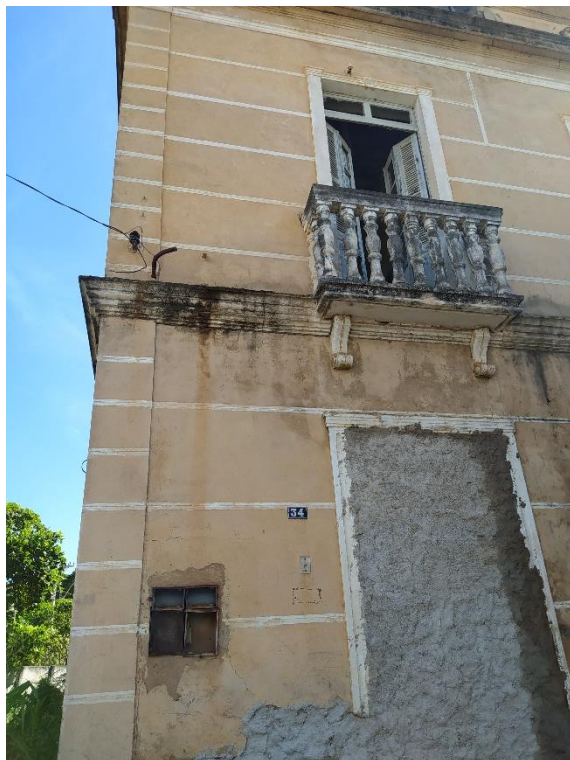
Foto 9 – Abertura de porta Hall escada fechada por alvenaria – fachada frontal
