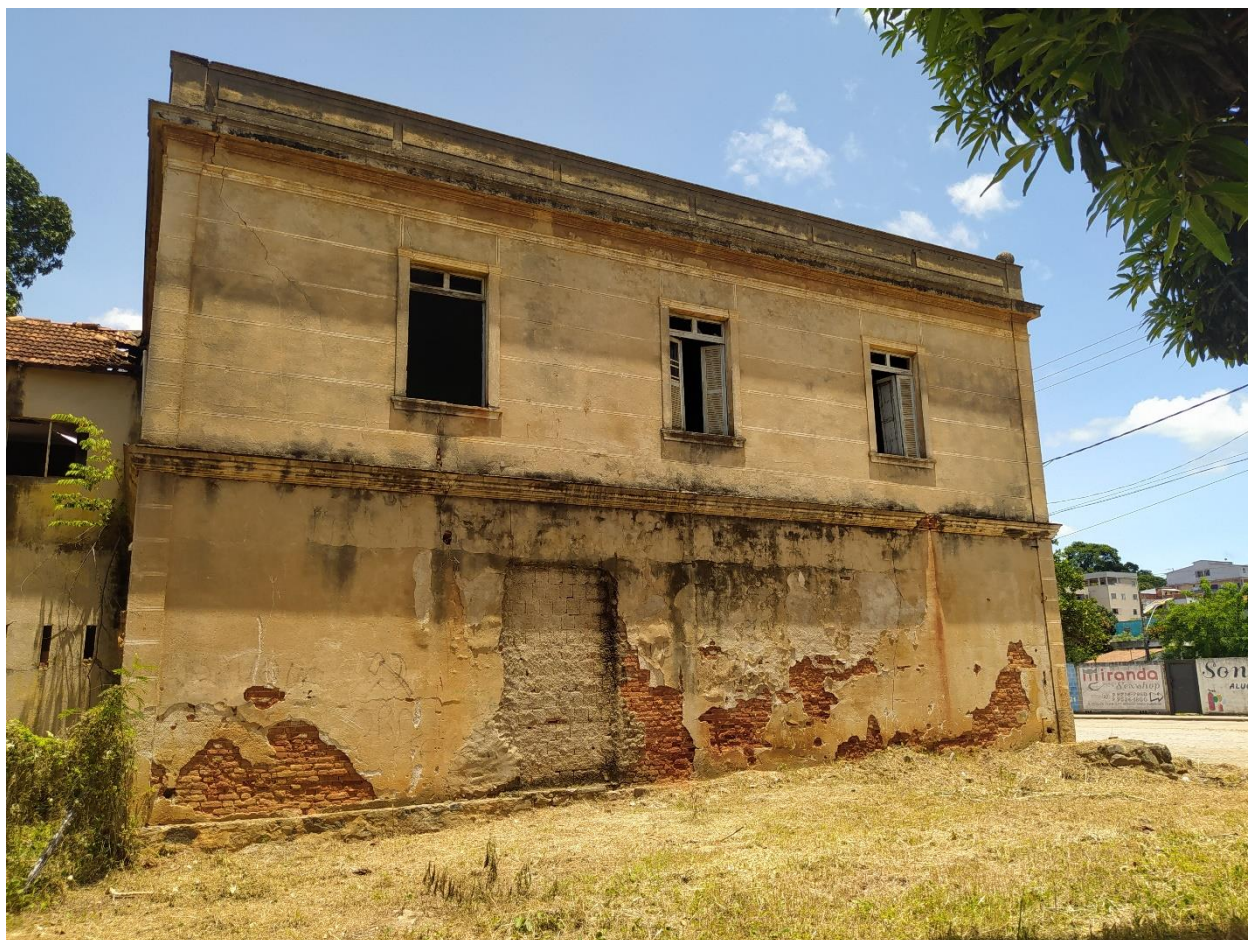
Foto 3 – Vista fachada lateral edificação existente – revestimento deteriorado a ser removido mantendo as linhas originais do local.
