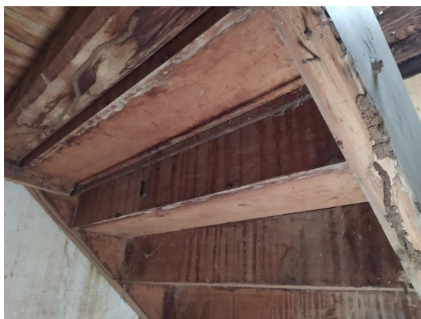
Foto 32 – Travamento inferior escada
