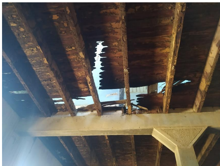
Foto 21 – Vista inferior trecho danificado por vandalismo e ataques de animais xilófagos.
