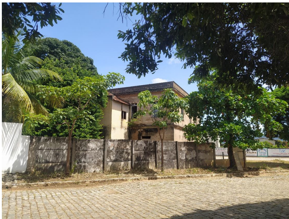
Foto 23 – Vista externa muro de placas
