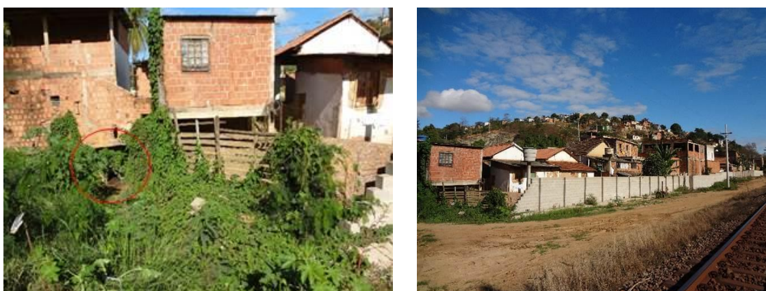
Figura 3-27 - Vista para o final da rede de drenagem nos fundos das casas localizadas na avenida Rio Doce.
