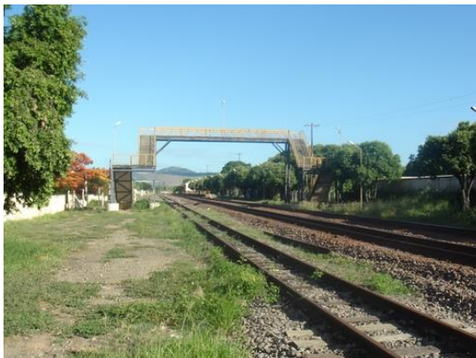
Figura 3-3 - Ferrovia Vitória Minas. Baixo Guandu-ES.
