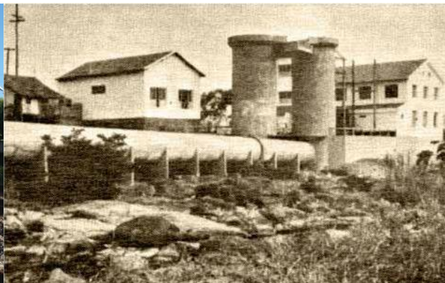
Figura 3-4 - Usina Hidrelétrica Von Lutzow, Baixo Guandu-ES.
