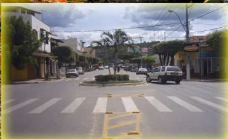
Pavimentação Asfáltica e Reurbanização
