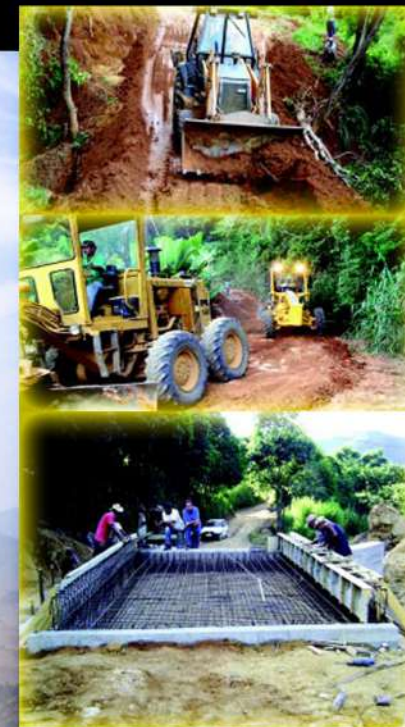
Recuperação das estradas do Interior e construção de Pontes
