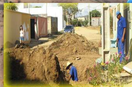
Obras de Saneamento Básico
