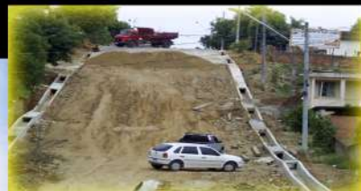
Calçamento de Ruas
