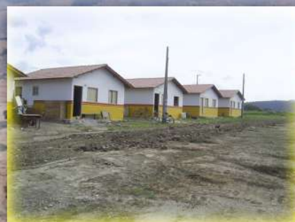
Construção de Casas Populares
