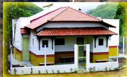
Construção do Posto de Saúde do Alto Lage
