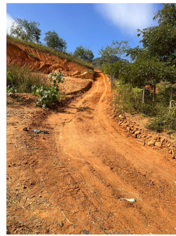
Foto - 001 Coord. x - UTM - 300.065.2748 Coord. y - UTM - 7.854.565.5887
