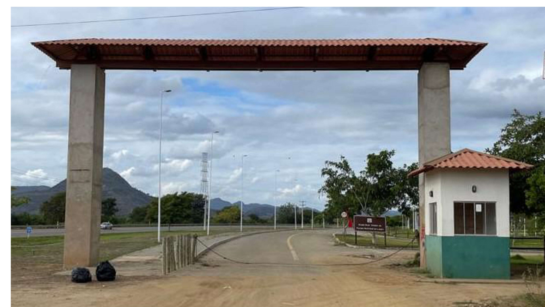
FOTO DO PÓRTICO IN LOCO
